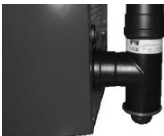
Fig. 66 - Fume conduit cleaning
